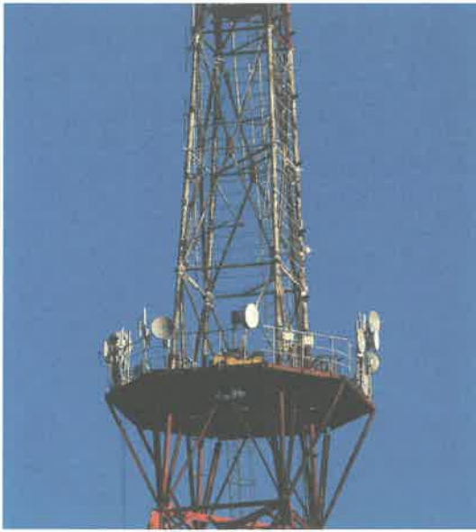
Antennenmast mit GSM- und UMTS-Antennen für Mobilfunk (850 – 1900 MHz), Richtfunkantennen (1 GHz - 40 GHz), Parabolantennen für Fernseh-Satelliteneempfang K U -Band (10,7 – 12,75 GHz), Riga, 2007; Fotograf: RIXC Aerial mast with GSM and UMTS antennas for mobile phones (850-1900 Mhz), directional antennas (1 GHz - 40 GHz), parabolic satellite dishes for satellite TV, K U -Band (10.7 – 12.75 GHz), 2007 Riga; Photo: RIXC
