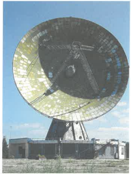
Parabolantenne RT-32 Radioteleskop mit verschiedenen, auswechselbaren LNBS (326 MHz, 10.6 GHz, 12 GHz, 15.75 GHz), VIRAC, Irbenē, Lettland; Foto: RIXC Parabolic satellite dish RT-32, radio telescope with various, exchangeable LNBS (326 MHz, 10.6 GHz, 12 GHz, 15.75 GHz), VIRAC, Irbenē, Latvia: Photo: RIXC
