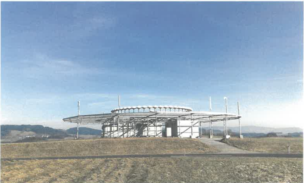
Funkfeuer (VHF Omnidirectional Radiorange) für Luftverkehr, Eidendorf (113,5 MHz), Österreich, 2008; Foto: Franz Xaver Radio beacon (VHF omnidirectional radiorange) for air traffic, Eidendorf (113.5 MHz), Austria, 2008; Photo: Franz Xaver
