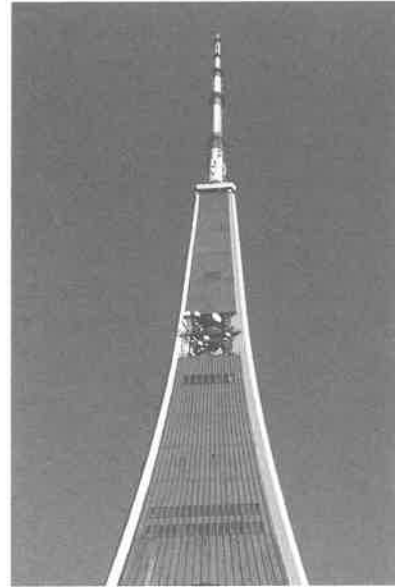
Fernsehturm, Vertikalantenne (Dipol), Richtfunk- antennen (1 GHz – 40 GHz), GSM und UMTS Anten- nen für Mobilfunk (850 – 1900 MHz), Riga, 2007; Foto: RIXC Television tower, dipole antenna, directional anten- nas (1 GHz – 40 GHz), GSM and UMTS antennas for mobile phones (850-1900 MHz), Riga, 2007; Photo: RIXC
